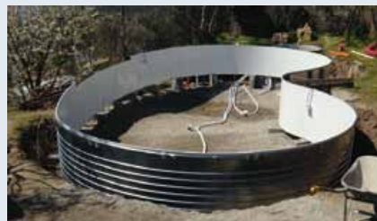
Il montaggio della struttura
