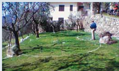
Il tracciato della piscina sul terreno
