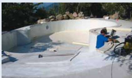
La posa del rivestimento in PVC
