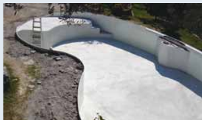
La realizzazione del fondo in calcestruzzo, montaggio degli accessori e dell'impianto di filtrazione
